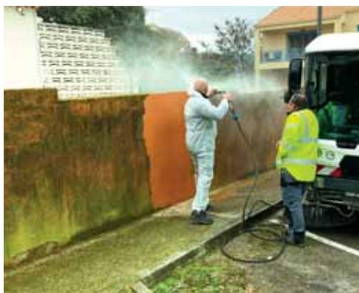
Après la réparation du portail, les agents des Services Techniques municipaux ont procédé au nettoyage à haute pression des murs et trottoirs entourant le parking. Cette opération a permis d'éradiquer la mousse qui s'était déposée sur les surfaces.
