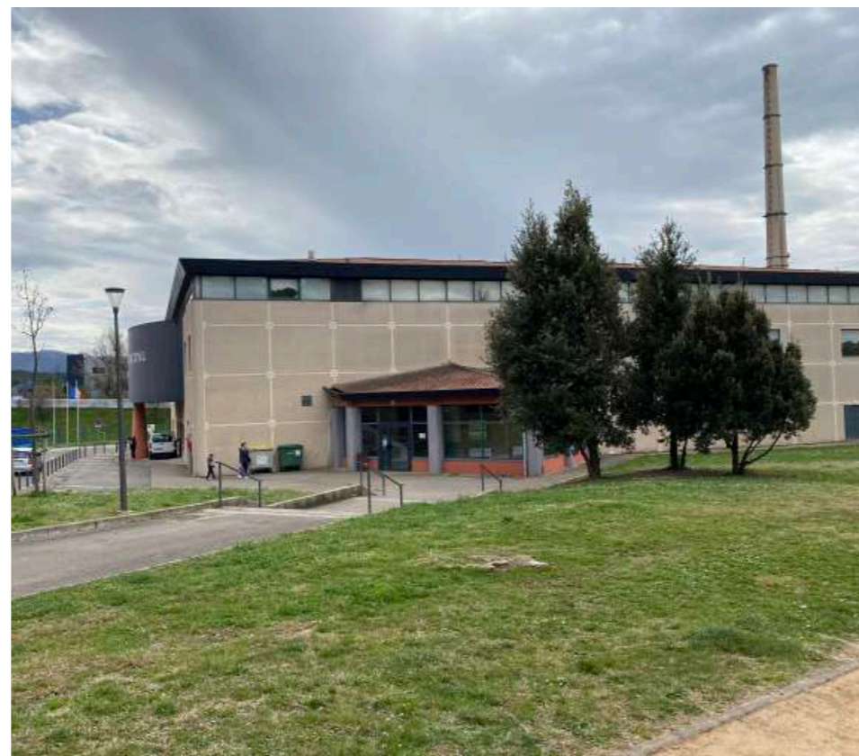
Façade Nord du gymnase
